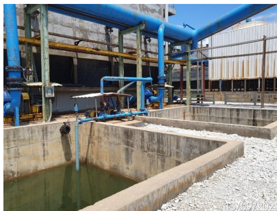
รูปที่ 17 บ่อพักน้ำทิ้งคอนกรีตรองรับน้ำทิ้ง จากระบบหล่อเย็น
