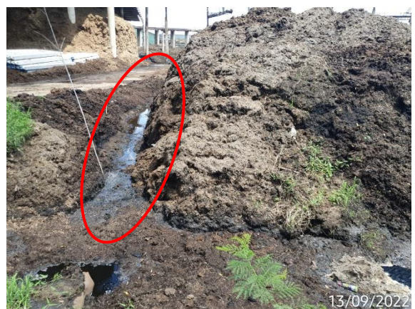
รูปที่ 5 รางระบายน้ำรอบลานกองกากอ้อย
