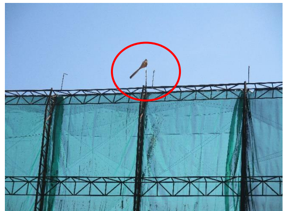
รูปที่ 11 การติดตั้งถุงลมนิรภัยทางลม
