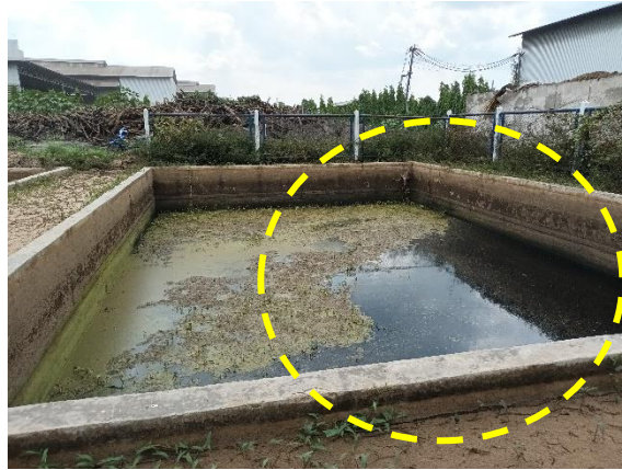
รูปที่ 18 บ่อพักน้ำทิ้งคอนกรีตรองรับน้ำทิ้งจากหม้อไอน้ำ
