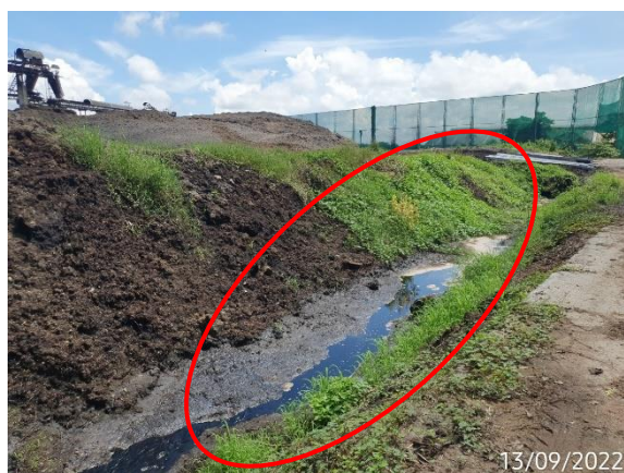
รูปที่ 5 รางระบายน้ำรอบลานกองกากอ้อย
